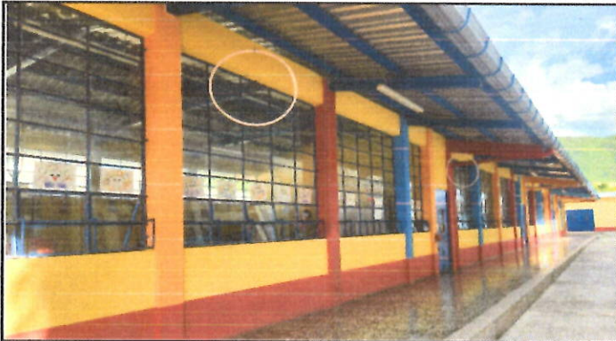
Foto1: Sustitución de Ventanas en mal estado
