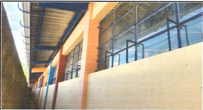
Foto 3: Sustitución de Ventanas en mal estado
